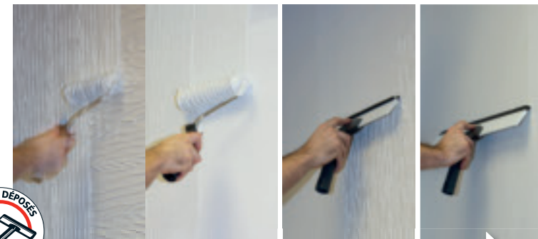
DÉPOSE EN ÉPAISSEUR (1 re PASSE)
